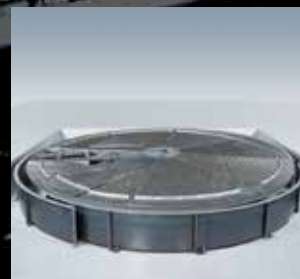
④コーナーアングル取付 コーナーアングル兼鋼板製型枠の組立。
