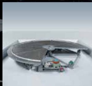
③天板取付 上部天板を取付し駆動装置の調整。
