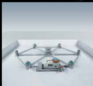
②下部ベース組立 下部ベースを配置し外周SW車輪・中心軸のレベル調整。
