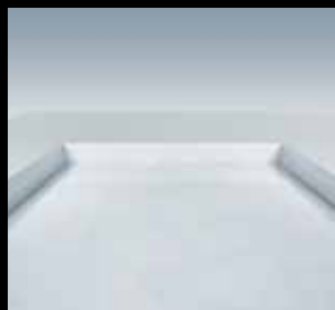
①施工前ピット フラットなピットに墨出して施工開始。
